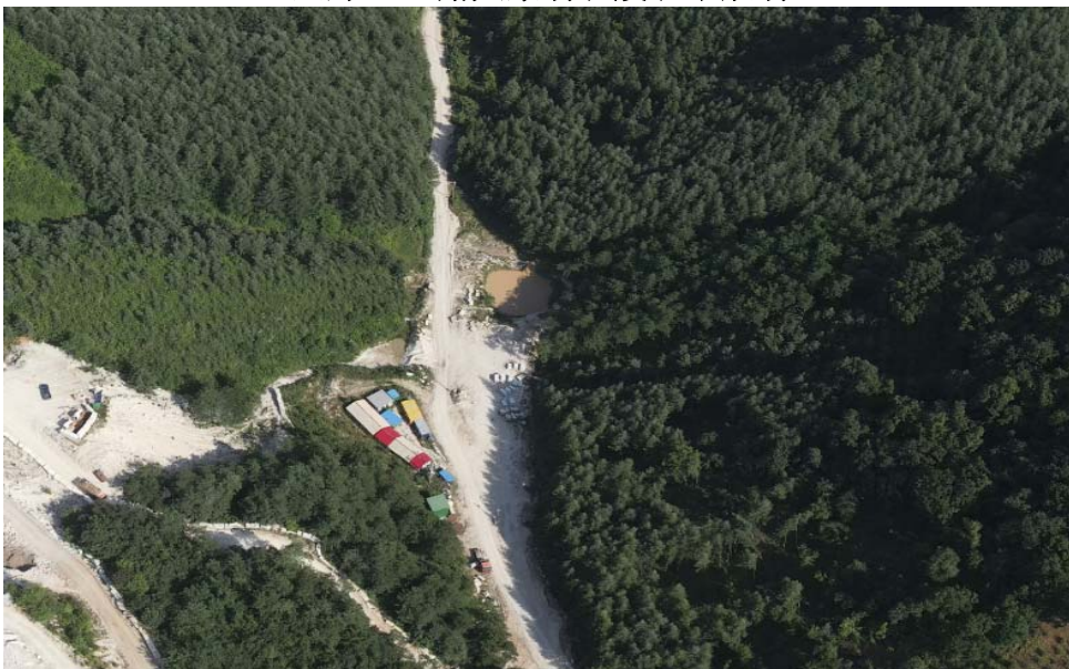
照片 3-2 工业广场和运输道路
