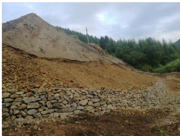
废石场1挡渣墙
