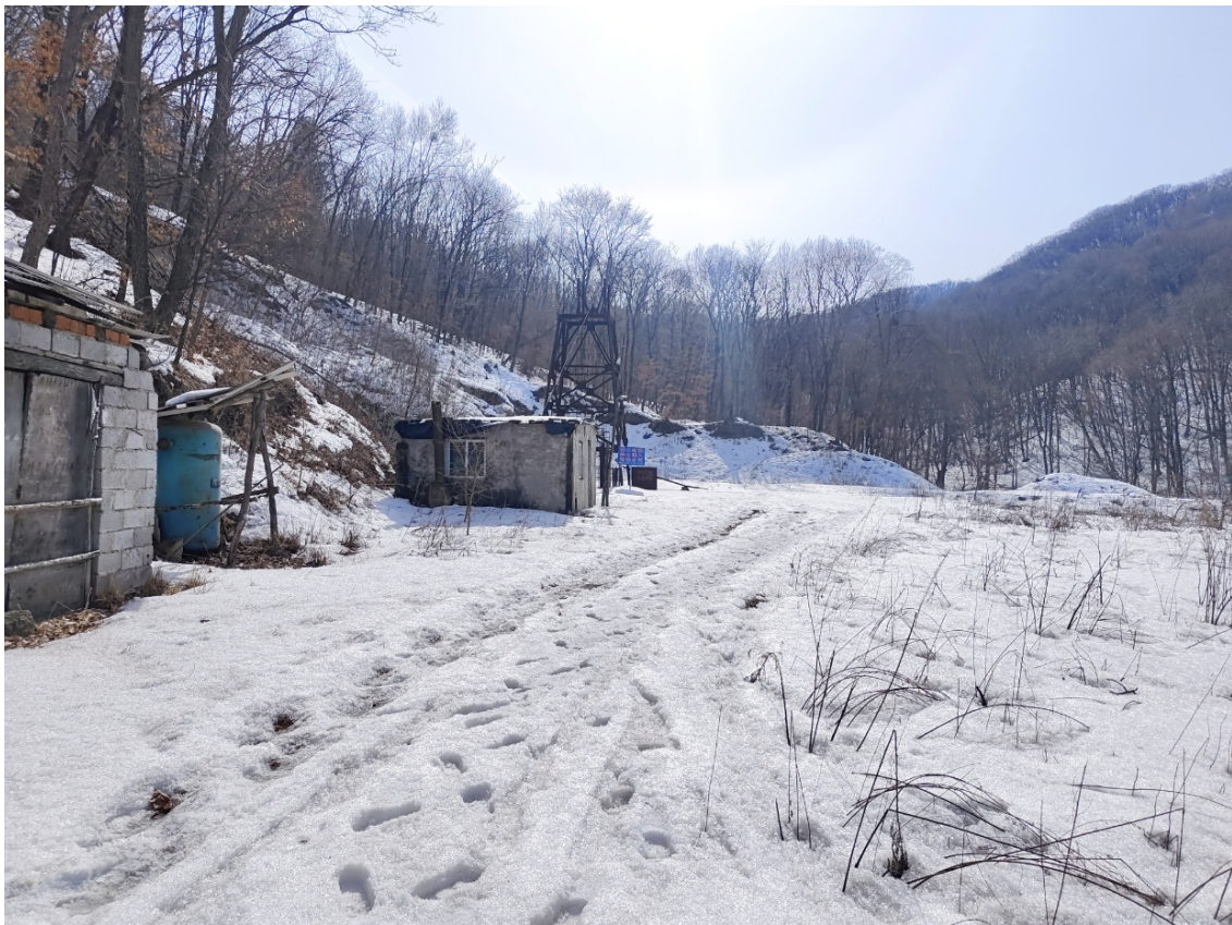
照片 3-3 竖井场地
