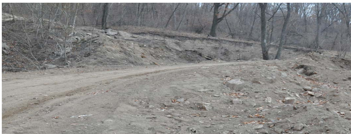
照片 3-6 东侧运输道路
